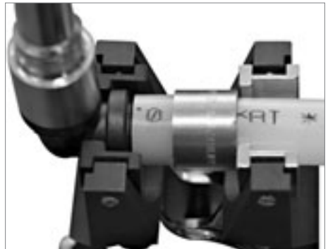
Монтаж отводов и тройников из PPSU с никелированными трубками
